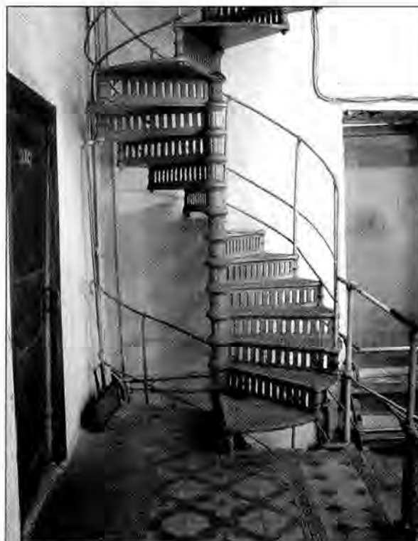
Чавунні сходи в інтер'єрі Центральної електричної станції. Фото автора 2007 р.
