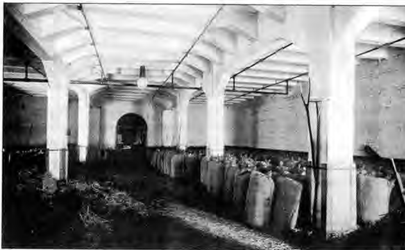
Рамні несучі конструкції складу цукрово-рафінадного заводу. Фото 1913 р.
