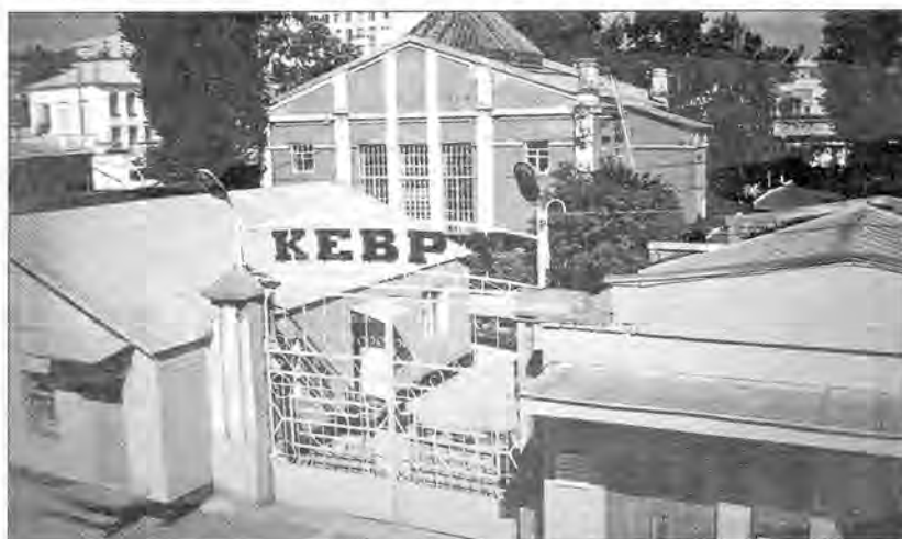
Сучасний вигляд колишніх залізничних майстерень (завод КВРЗ, прохідна). На задньому плані – механічна лабораторія О. П. Бородіна. Фото автора 2003 р.
