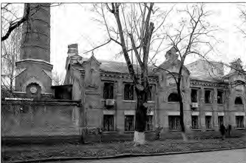
Сучасний вигляд Введенської каналізаційної насосної станції з вул. Ратманського. Фото автора 2007 р.
