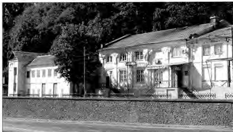
Сучасний вигляд першої електричної станції міської залізниці. Фото автора 2006 р.
