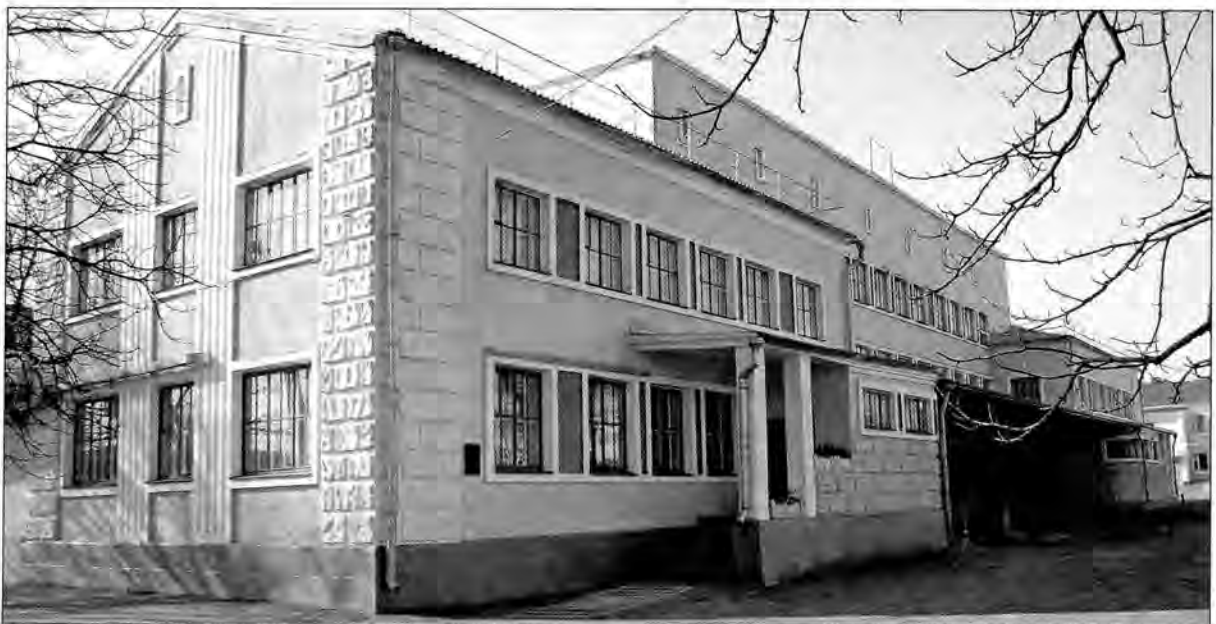
Загальний вигляд головного корпусу Хлібокомбінату № 4. Фото автора 2008 р.
