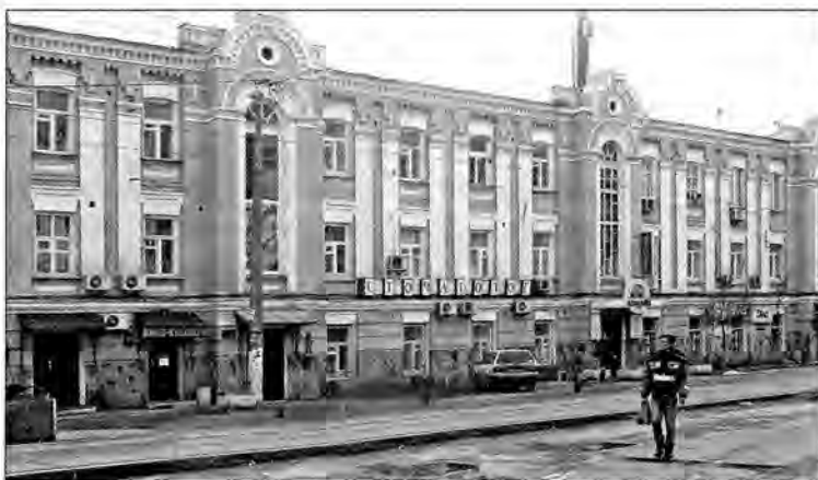
Колишній деревообробний цех Південноросійського машинобудівного заводу в складі сучасного виробництва “Ленінська кузня”. Фото автора 2008 р.
