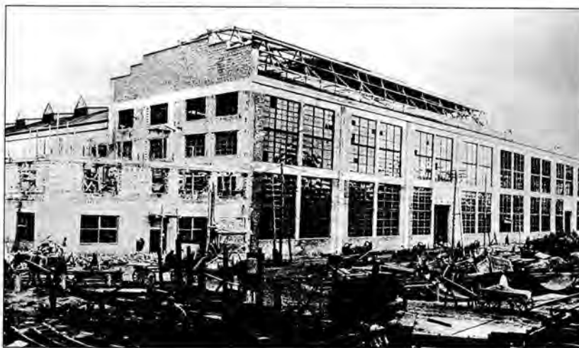
Спорудження корпусу заводу “Більшовик” (з кн. “Будова соціалістичного Києва”).
