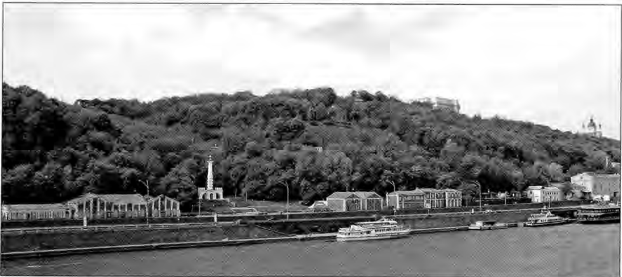
Водогінні споруди на набережній Дніпра біля Поштової площі. Фото автора 2007 р.
