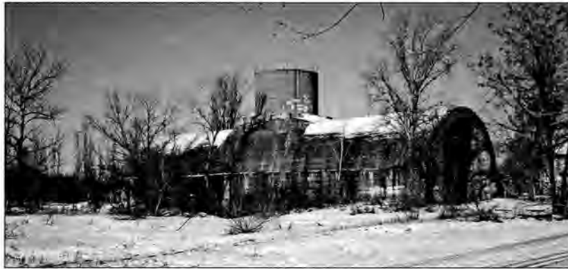
Залізобетонна конструкція кесону на Оболоні. Сучасне фото.
