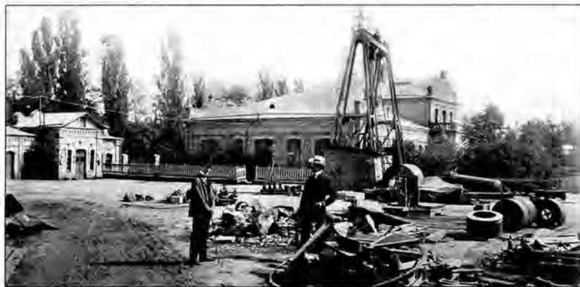
Я. Гретер та Й. Криванек на будівництві заводу. Фото кін. ХІХ ст. (матеріали з фондів музею заводу “Більшовик”).
