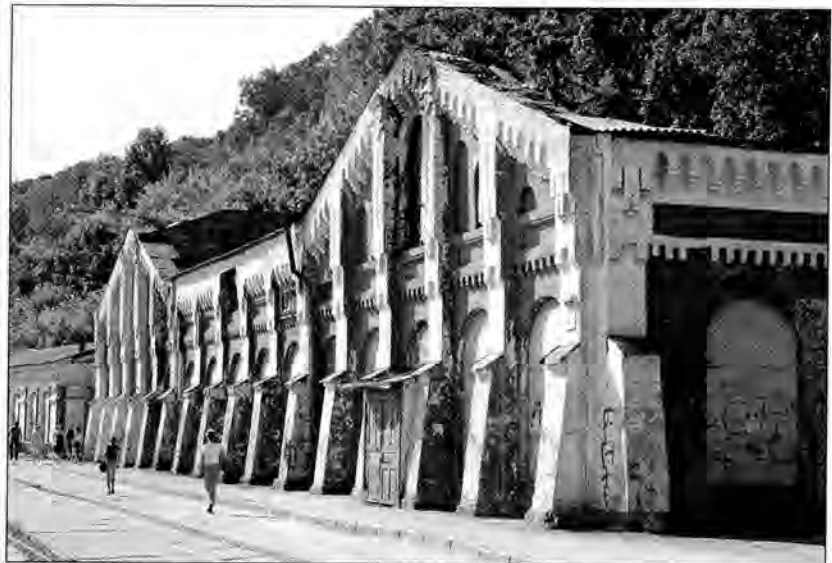
Нижня нова машинна станція водогону. Сучасний вигляд. Фото автора 2007 р.
