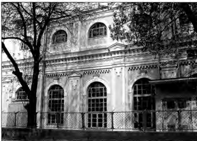
Київська Центральна електростанція, головний корпус, фасад по вул. Андріївській (фрагмент). Фото автора 2007 р.
