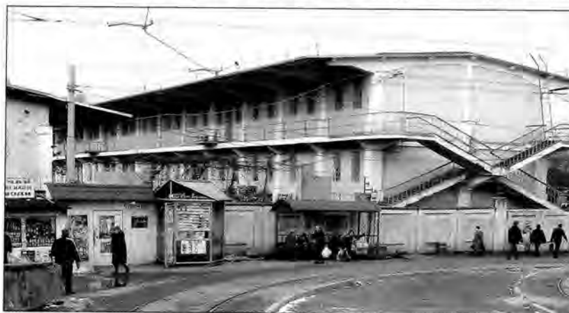
Залізобетонні конструкції пакгаузів колишньої митниці, поч. XX ст. Фото автора 2008 р.
