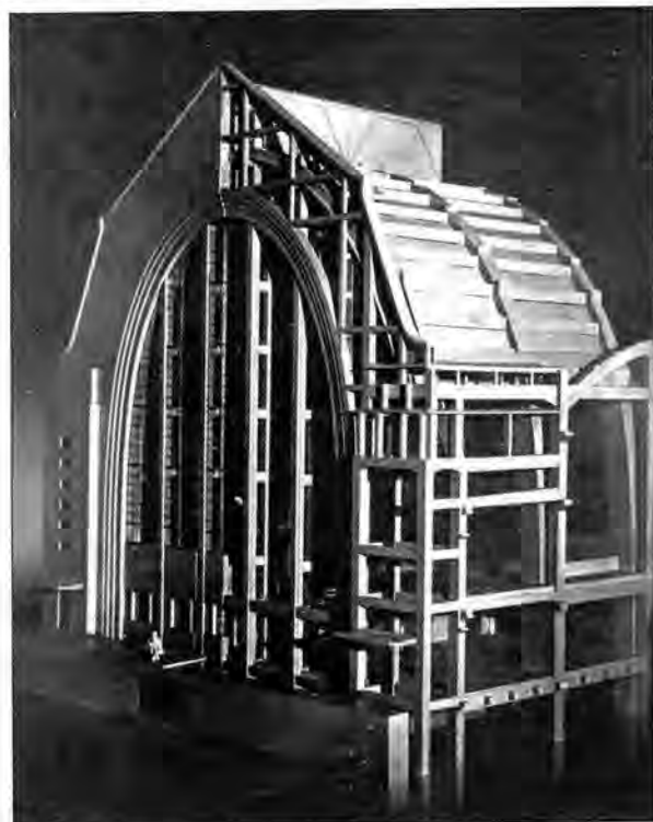
Конструкції перекриття головного вестибюлю кийського вокзалу. Модель, 1930 р., архітектор О. М. Вербицький (фото з архіву автора).
