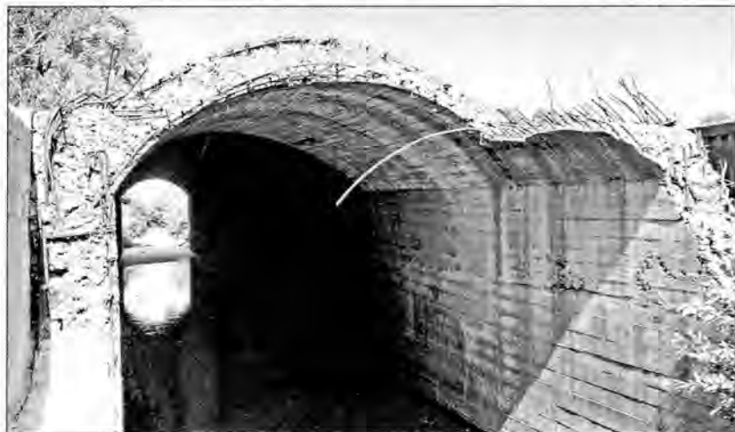
Залізобетонна конструкція тунелю в районі Жукова острова (Титул № 5). Сучасне фото.
