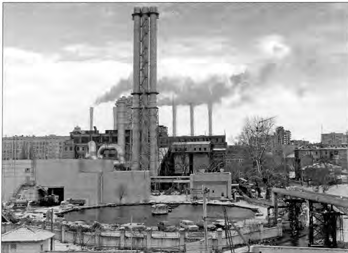
ТЕЦ-3 (СТ-1). Загальний вигляд з боку шляхопроводу. Фото автора 2008 р.
