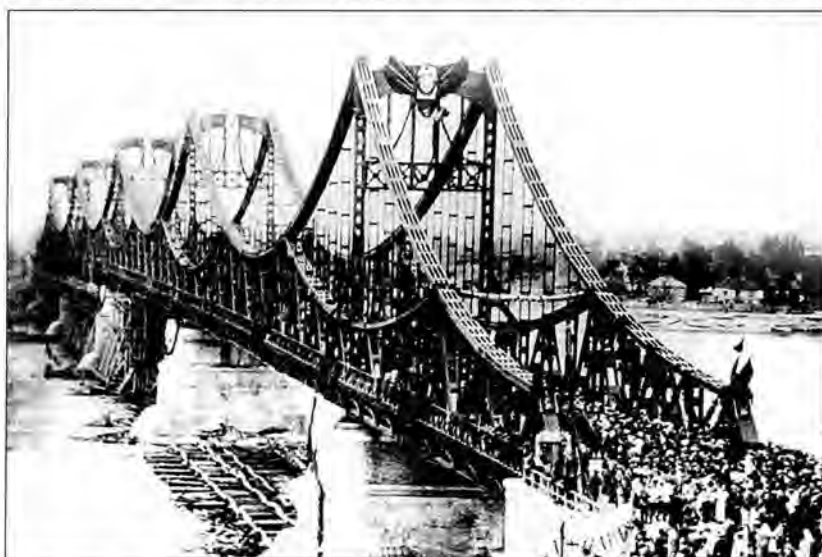
Відкриття мосту ім. Євгенія Бош. Фото 1925 р.
