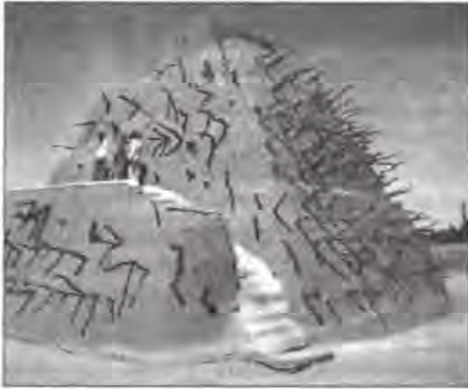
Слева Гробница династии аскиев (султанов) Сонгай (Мали) в Гао – столице империи с 1493 г. Построенная из глиняных кирпичей, она имеет высоту более 10 м
