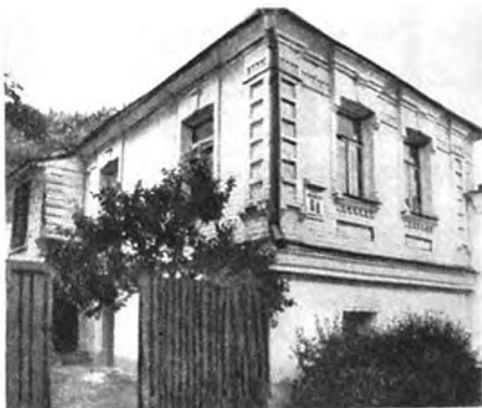
Флоровский монастырь. Кельи, корпус № 7. Вид с юго-востока.
