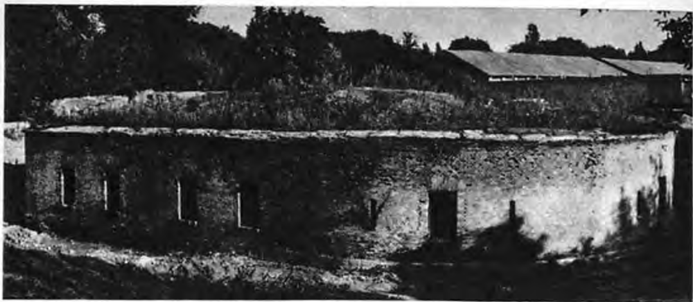
Киевская крепость. Капониры третьего полигона Госпитального укрепления. Вид с запада.
