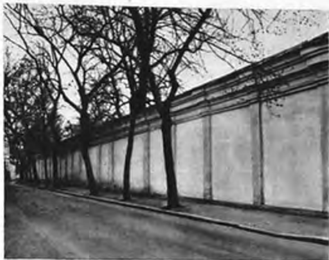
«Софийский музей». Стены. Вид с юго-запада.
