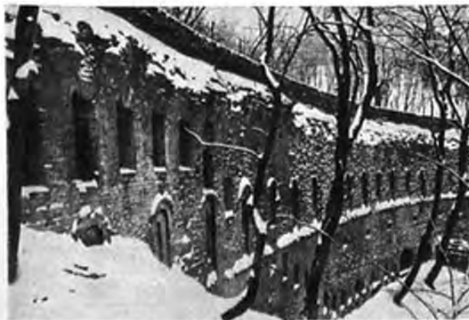
Киевская крепость. Нижняя полукруглая подпорная стена. Вид с юго-востока.
