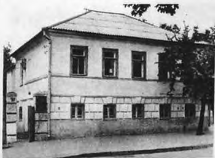
Жилой дом по ул. Хоревой, 6. Общий вид.
