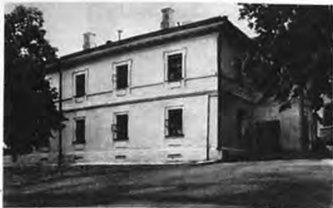
Братский корпус на Дальних пещерах (корпус № 50). Вид с юга. План первого этажа.
