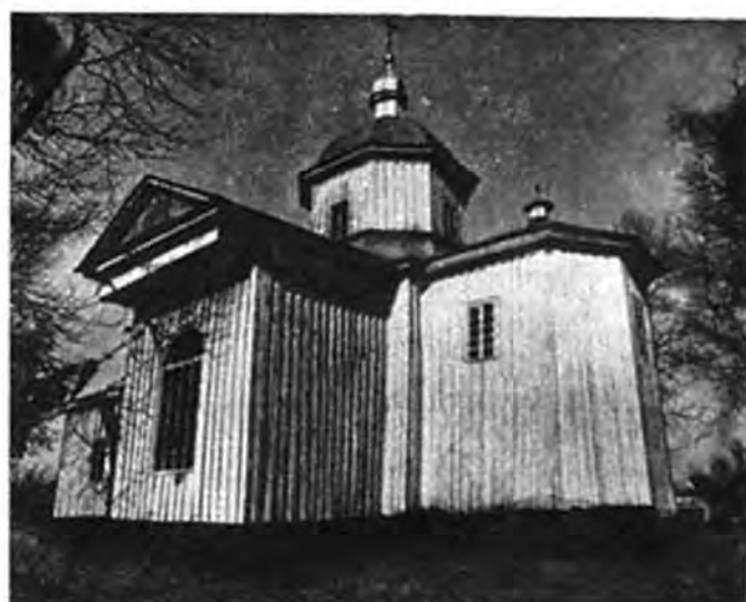
Церковь Сошествия Святого Духа в с. Шкаровке. Вид с юго-востока.
