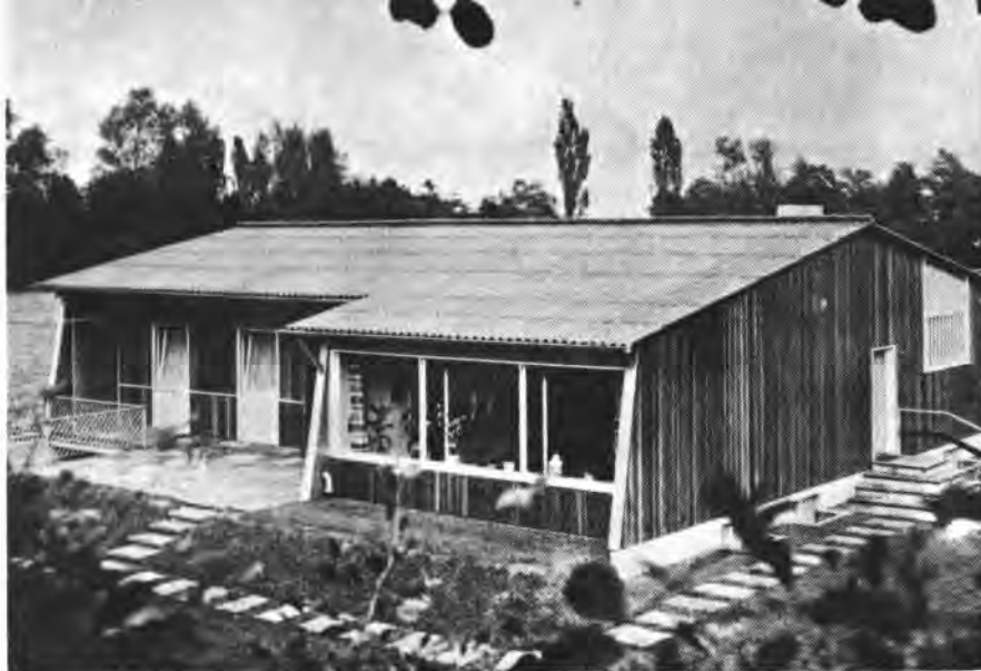
Obr. 152. Prízemný rodinný dom s podpivničením, vhodný pre päťčlennú až šesťčlennú rodinu (NSR). Priečelia sú obložené drevom. Pôdorysné riešenie dôsledne diferencuje dennú a nočnú časť bytu. Ku kuchyni a schodom do pivnice vedie aj hospodársky vstup. Zastavaná plocha je 178,0 m 2
