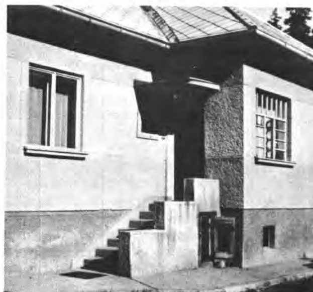
Obr. 99. Ukážky nevhodných úprav vstupov do rodinných domov cez vonkajšie schodiskové rameno.
